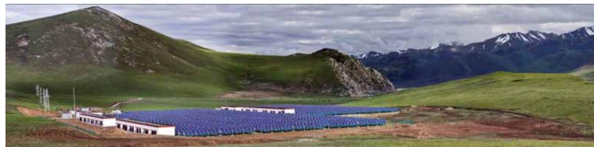
图 4-10 青海玉树水光互补微电网：水电 12MW，光伏 2MW，蓄电池组 15.2MWh。建成时间：2011 年 12 月
