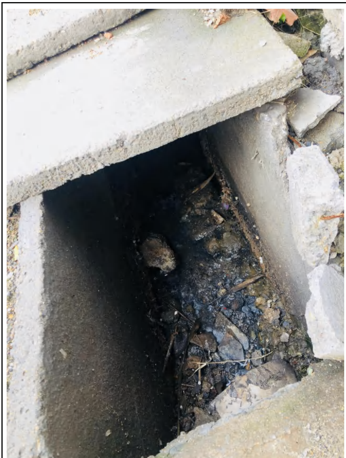
地块内下水道现场踏勘照片
