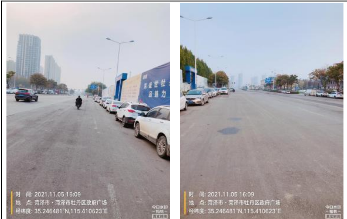
相邻地块南侧嘉陵江路在建小区
