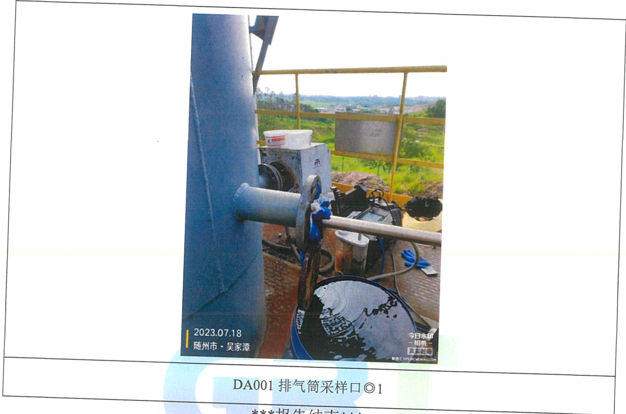
附图 2：现场检测照片
