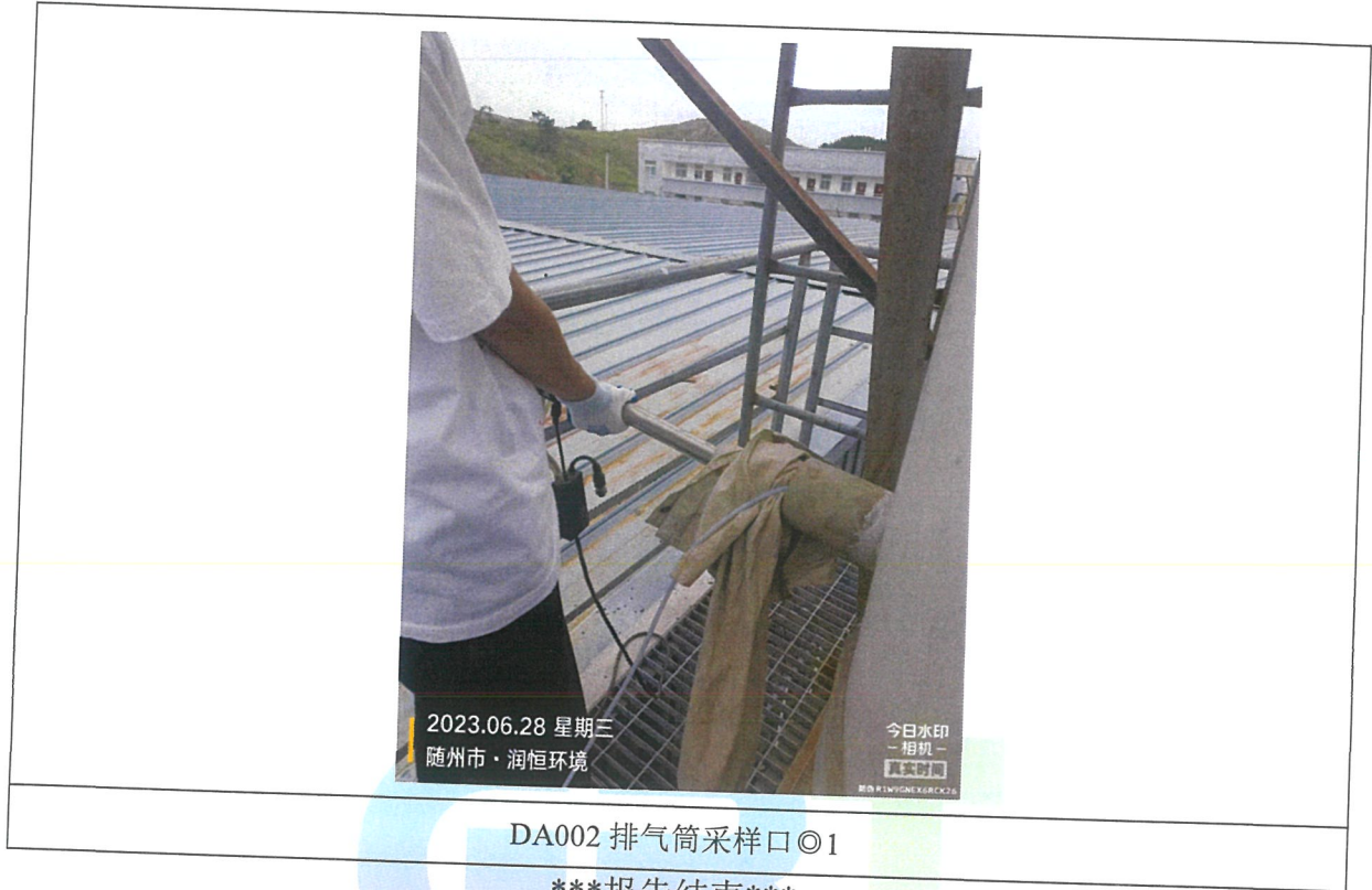
附图：现场检测照片
