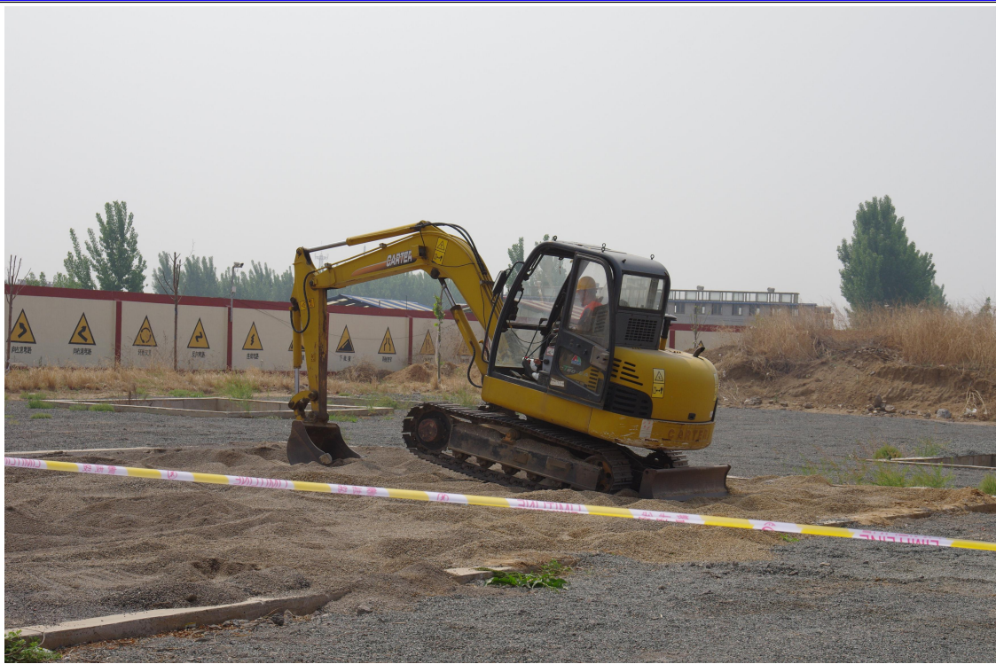
实训基地挖掘机实训场地
