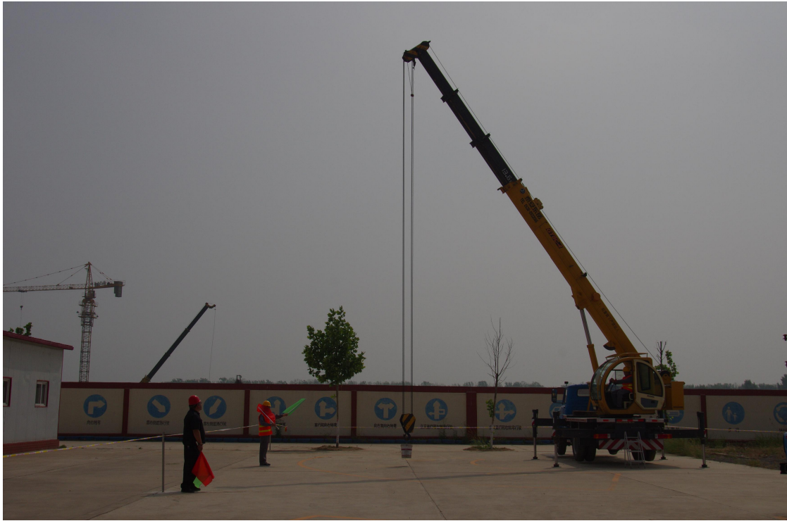
实训基地起重机实训场地
