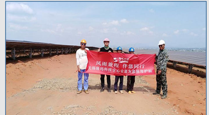
越南潘切 49MW 光伏电站
