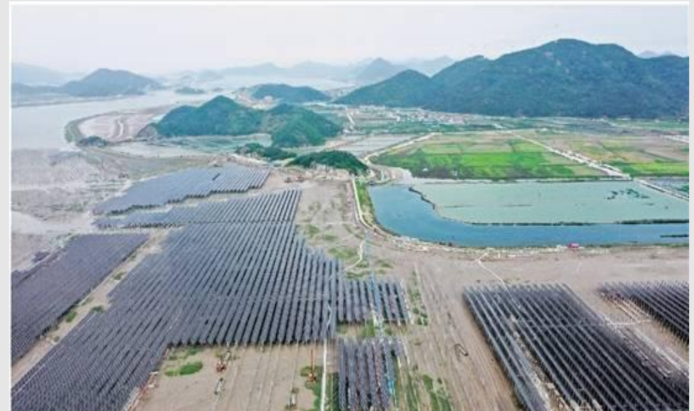
唐象山县高塘岛乡 长大涂光伏300MW项目
