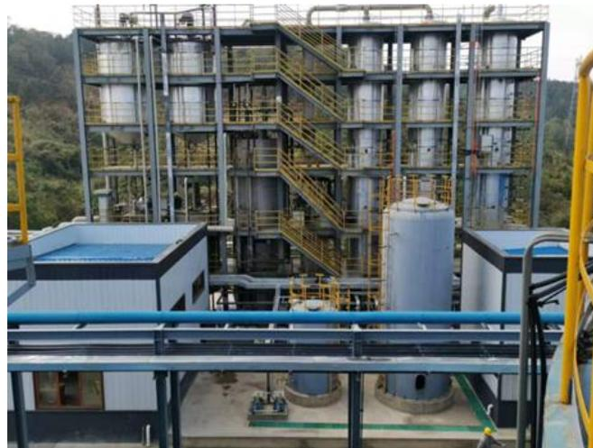
500t/d渗滤液脱氨工程
