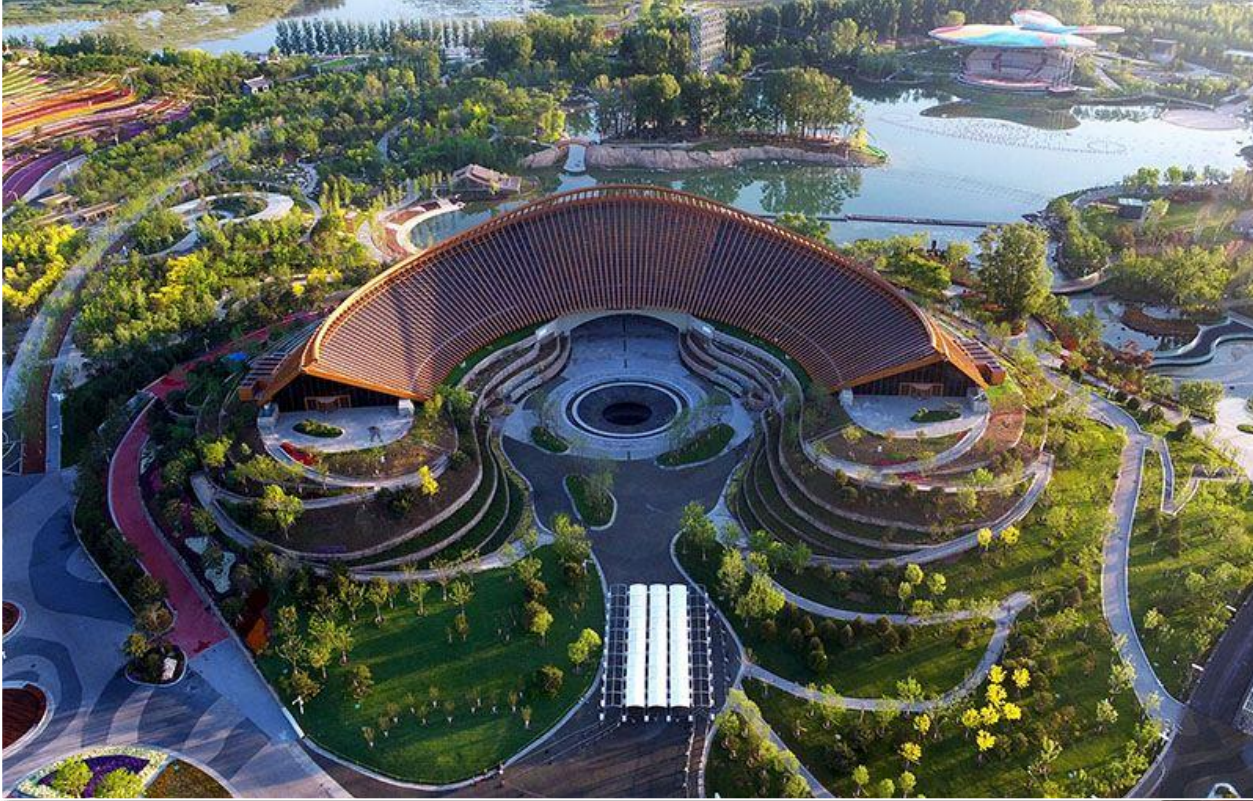
2019年北京世园会彩 色透光光伏屋顶
