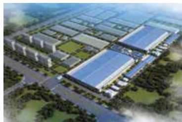
通威太阳能(安徽)有限公司 年产2.3GW高效晶体硅太阳能电站工程
