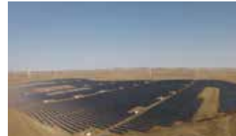
包头市采煤沉陷区光伏领跑技术基地 100MW 发电项目
