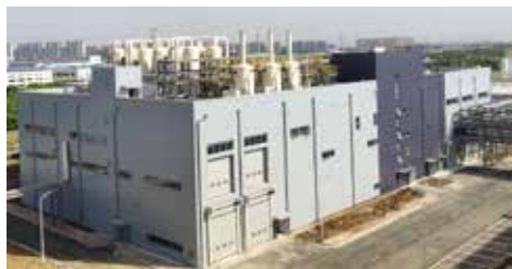
海辰半导体(无锡)有限公司8英寸非存储晶圆厂房建设项目—WWT系统工程
