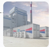
河南郑州万邦物流园 60MW分布式光伏项目
