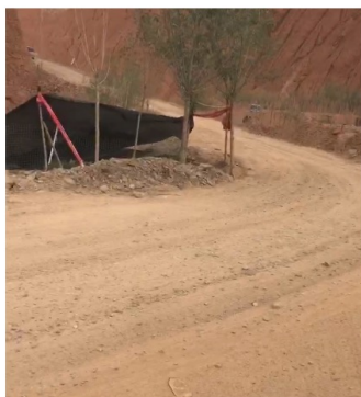
路况一：转弯半径较大而且转弯+爬坡，超过车型负重的装载，通过率较差
