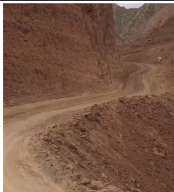
路况三：爬坡路段土质松软，不宜采用过重的车型短拨，容易造成侧滑或者翻车
