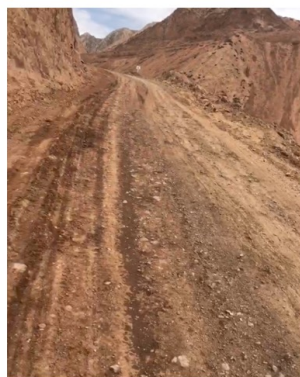
路况四：部分路段坡度超过40度，对车量的爬坡性能要求极高
