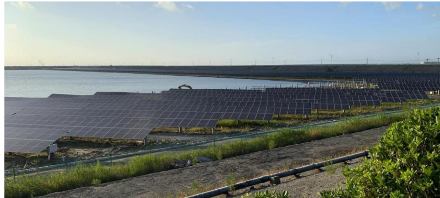
江苏吕四港126MW N型地面电站项目
