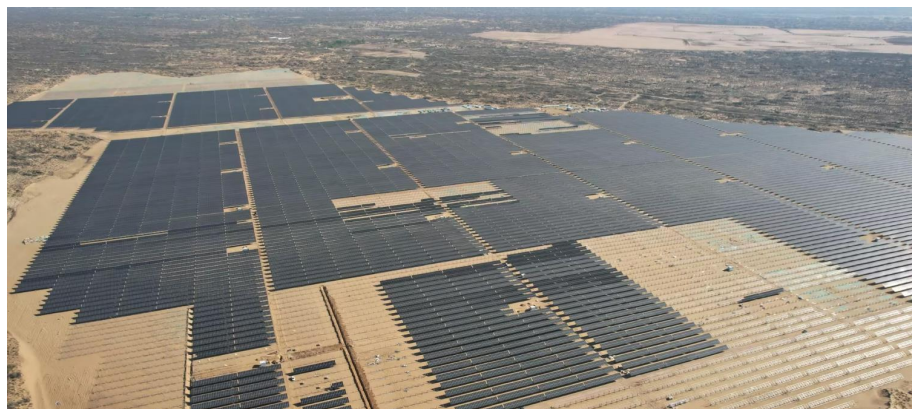
陕西榆林150MW N型地面电站项目
