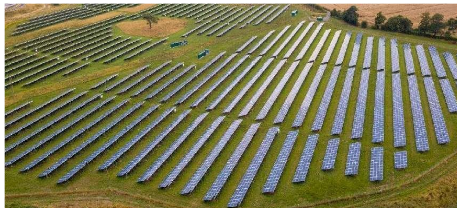
欧洲德国5MW N型组件项目
