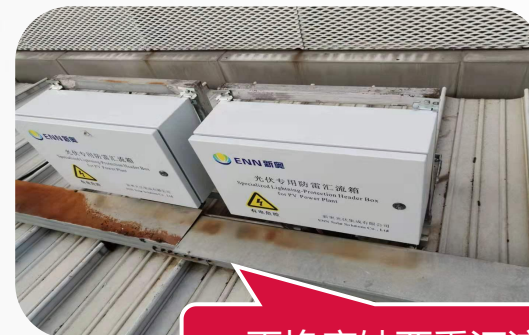
更换腐蚀严重汇流箱
