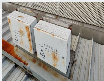
电缆老化、设备防护等级不足、逆变器故障、低/零电流组串
