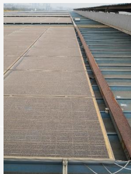
铁锈、灰尘、油漆等污染/组件拆除
