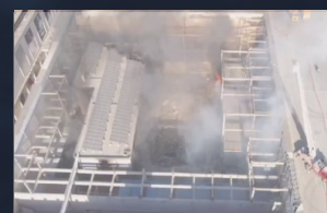
北京某储能电站起火
