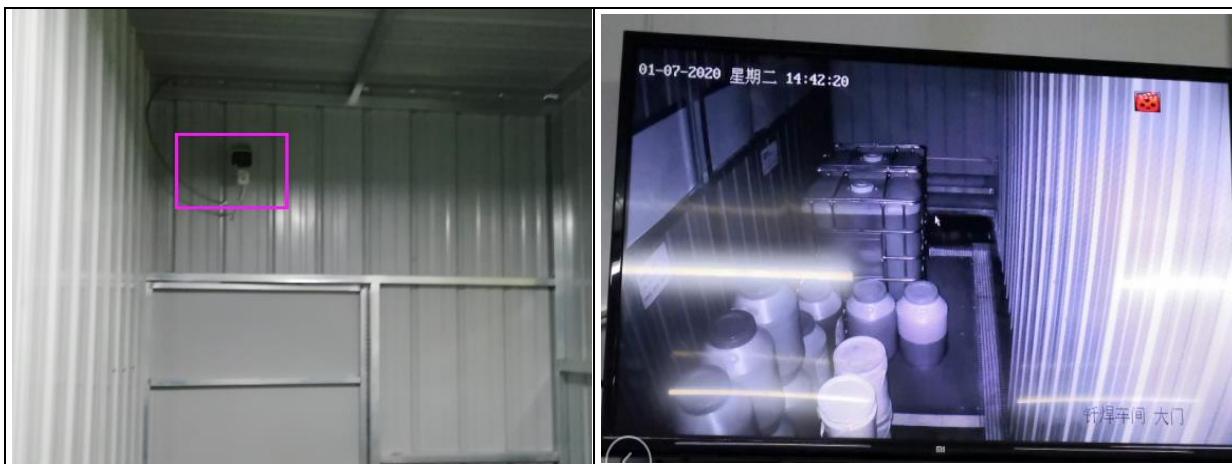
危废仓库内部视频监控
