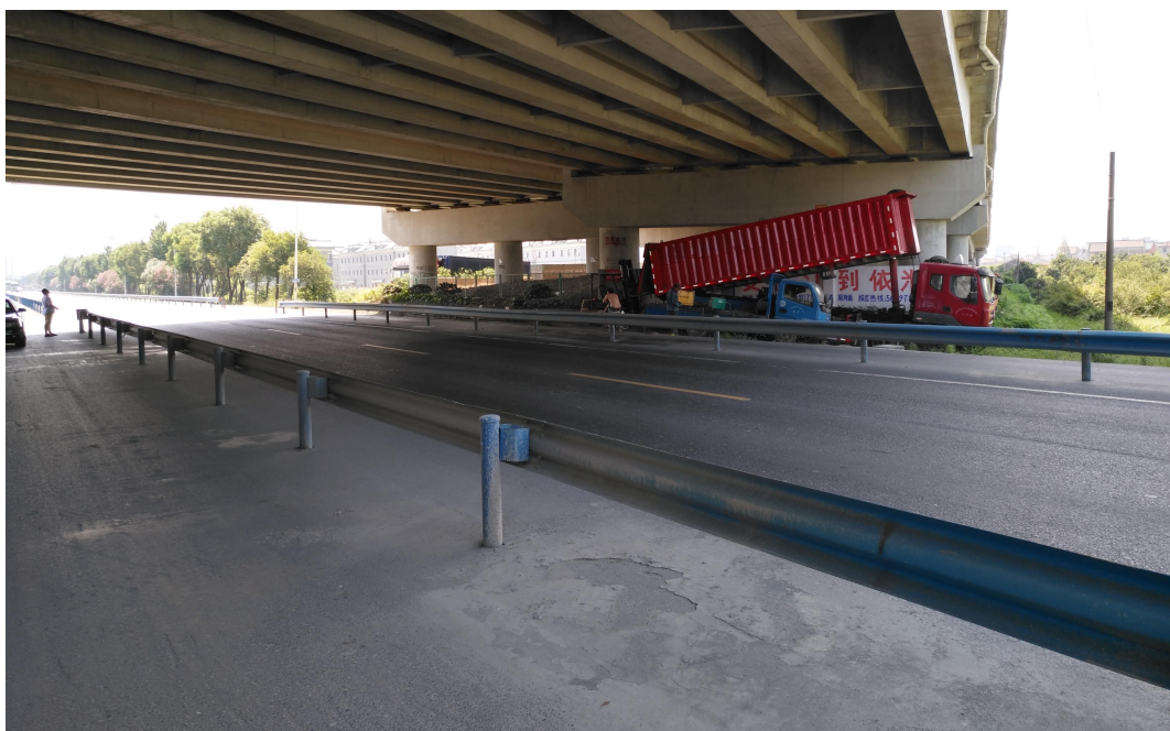
图 2.12-2 临浦快速路杭甬运河桥现状（二）
