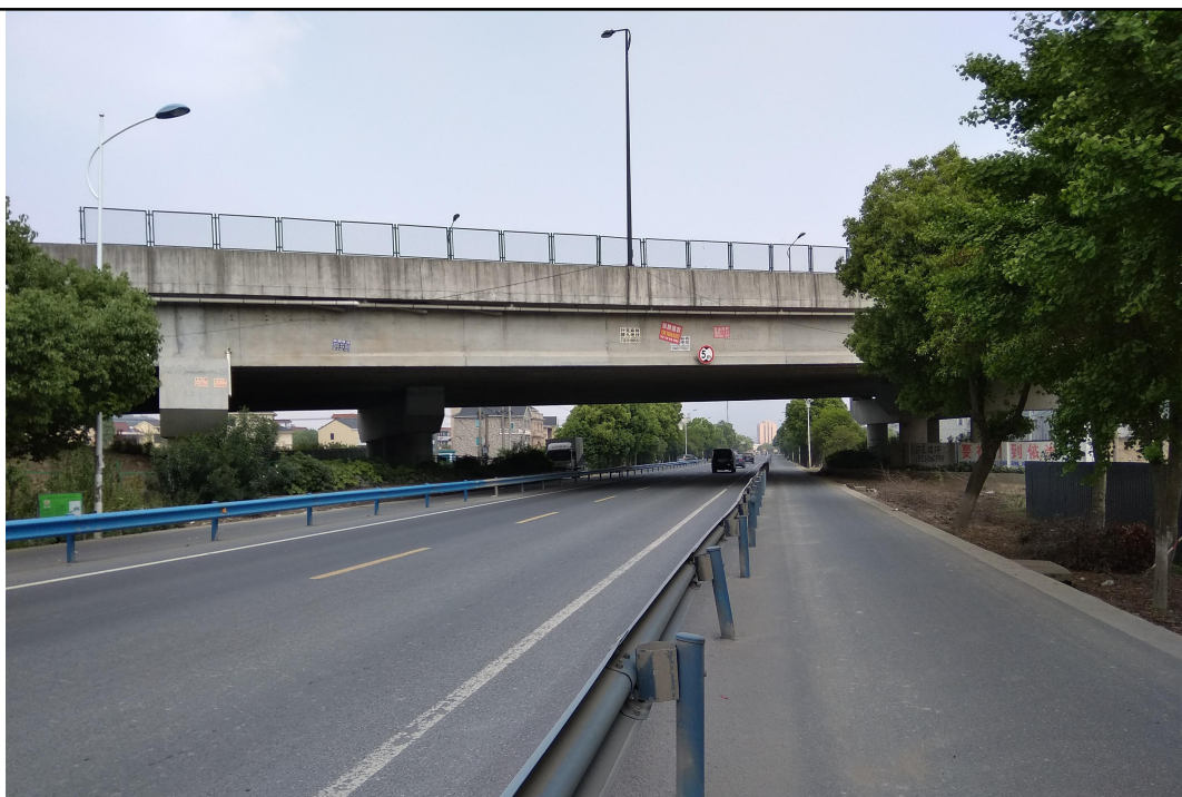
图 2.12-1 临浦快速路杭甬运河桥现状（一）
