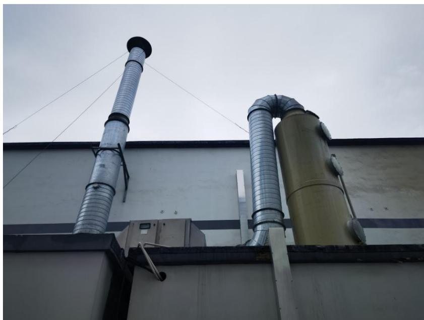
水喷淋+高压静电+15m排气筒DA001
