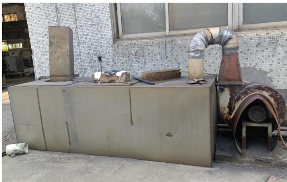
打磨粉尘处理设施<水箱过滤除尘后无组织排放>
