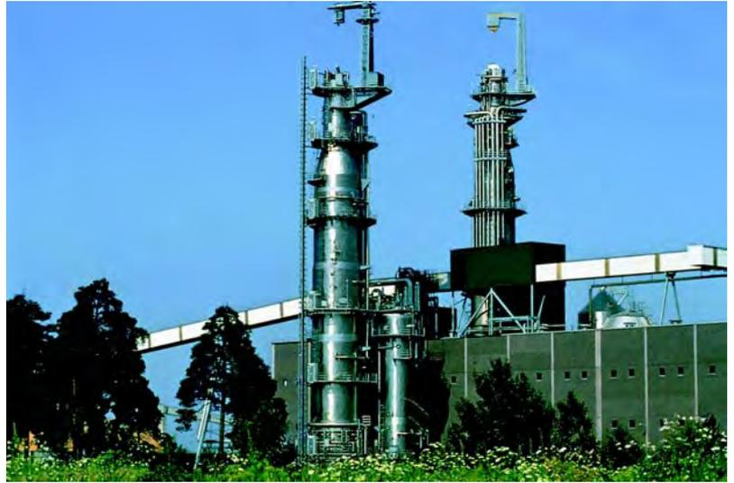
瑞典 Sodra Cell Mönsteras 纸浆厂的 2205 双相不锈钢硫酸盐纸浆连续蒸煮器和浸渍塔（来源：Kvaerner Pulping）
