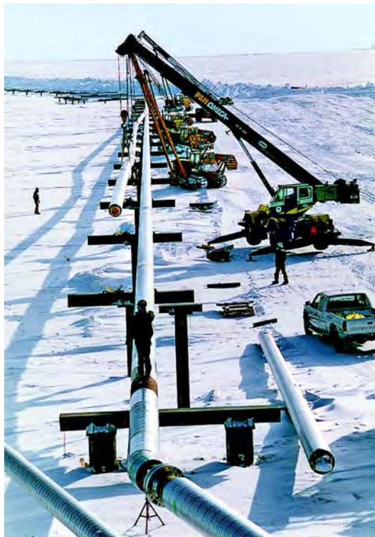
普拉德霍湾垂直支撑架上隔热的 24 英寸 2205 管的安装 (来源: Arco Exploration and Production Technology)
