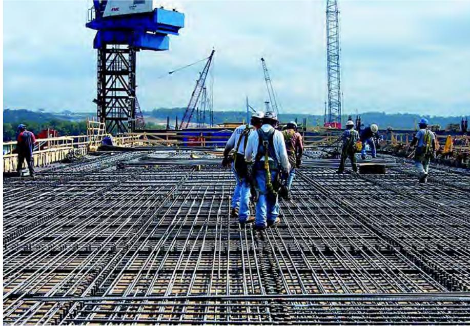
一座大型桥梁桥面上双相不锈钢钢筋的安装
