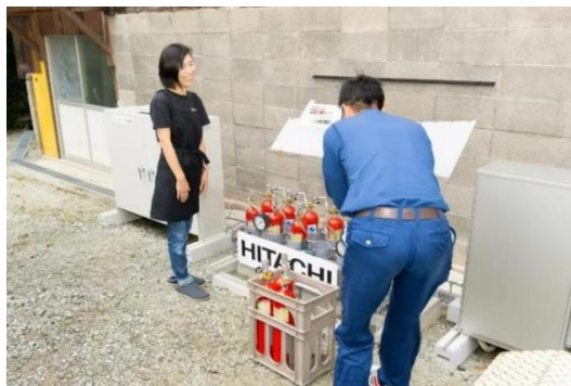
这是氢气罐配送情景
