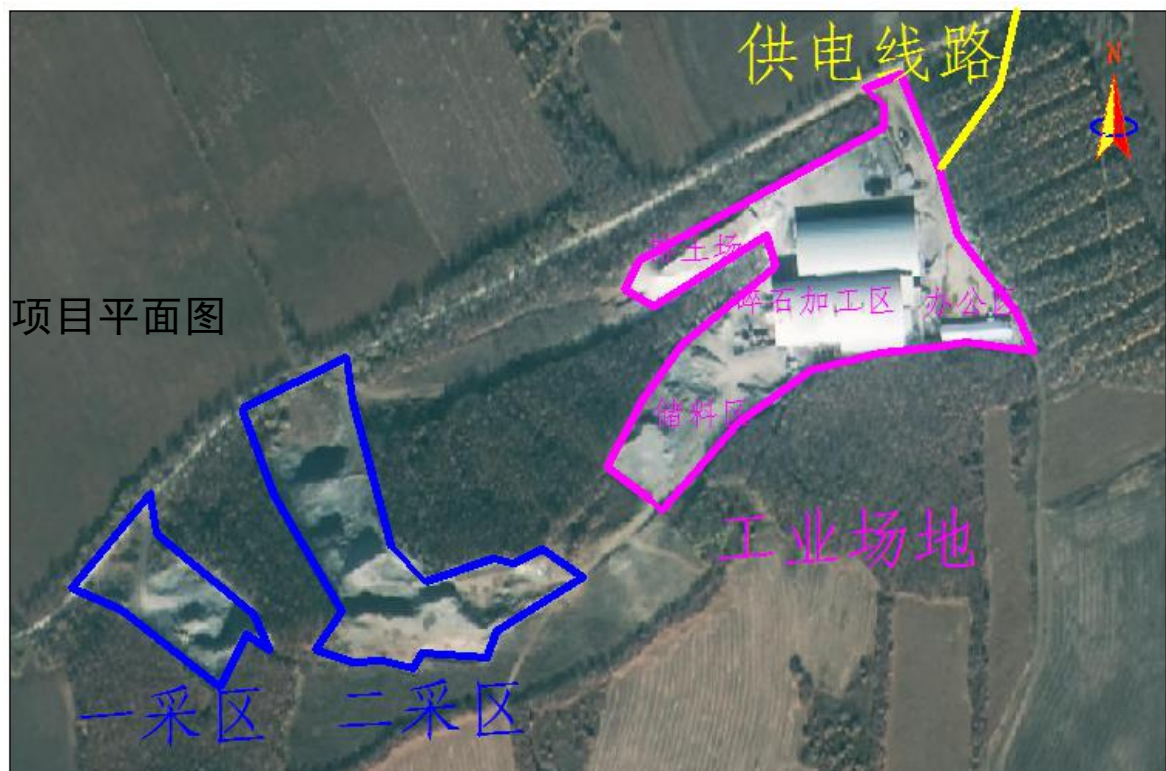
露天采区及工业场地航拍图
