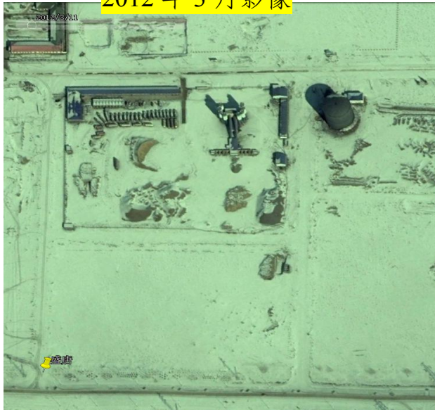
项目开工卫片
