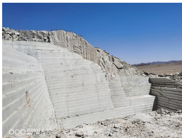
照片 2-2 已有露天采坑
