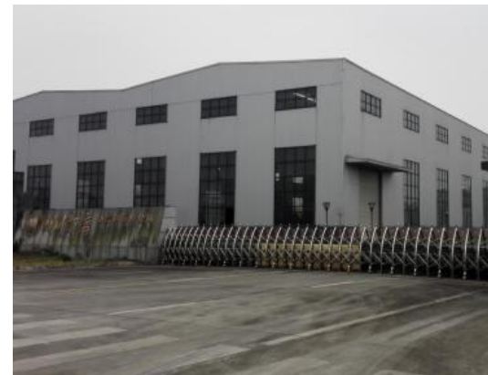
东侧四川万高钢结构有限公司
