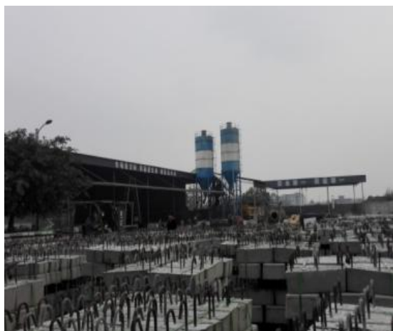
南侧水泥砼块预制场
