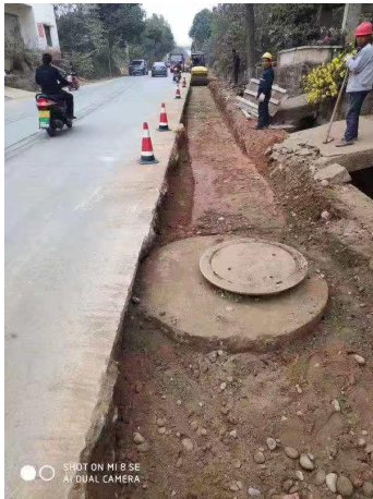
管网施工期照片
