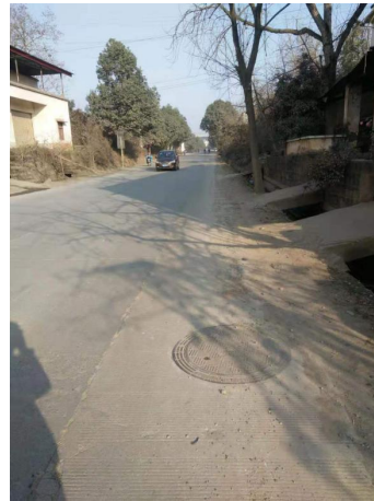
施工扰动区恢复情况
