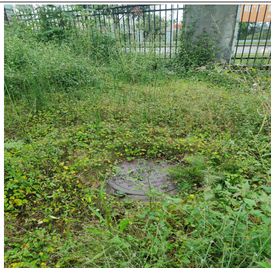
污水处理排口
