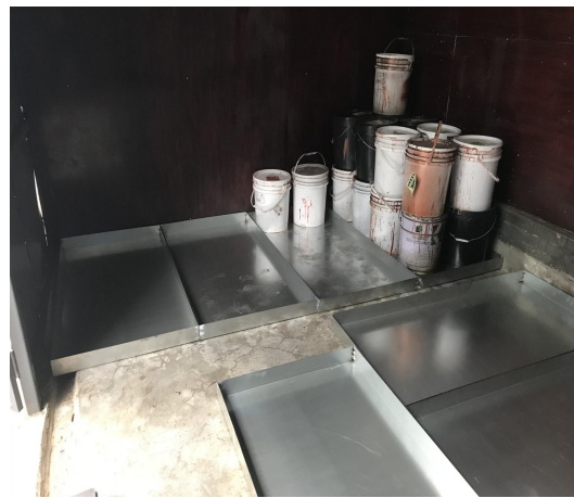
危废暂存间防渗（混凝土+丙纶防水材料+防渗混凝土+防渗托盘）
