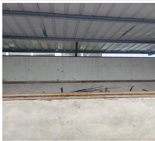
一般固废暂存间
