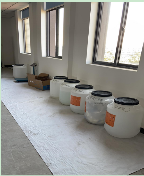
废液暂存点地面铺设的防水毡布
