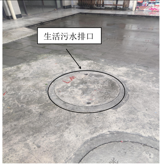
生活污水接市政排口
