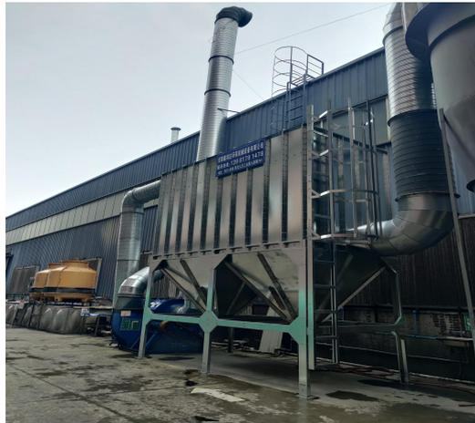
旋风除尘器+布袋除尘器及2#排气筒
