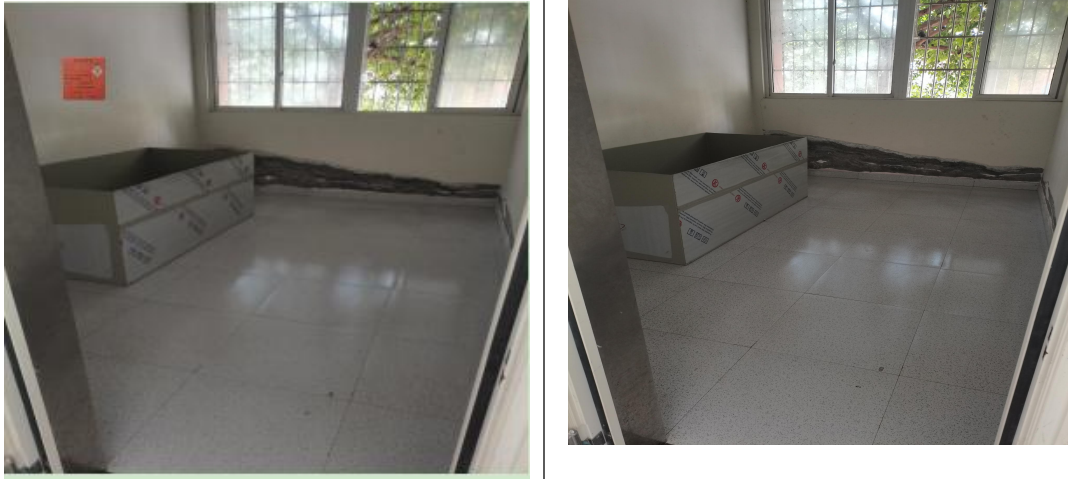
C区危废暂存间
