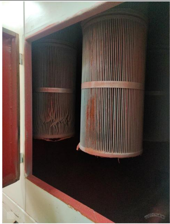
喷塑工序转翼式滤芯回收装置
