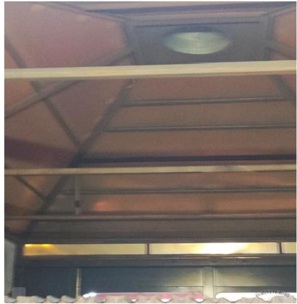
激光切割机内部自带抽风装置
