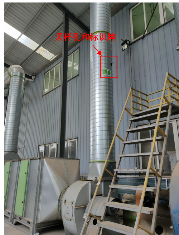
排放口标识标牌及采样孔
