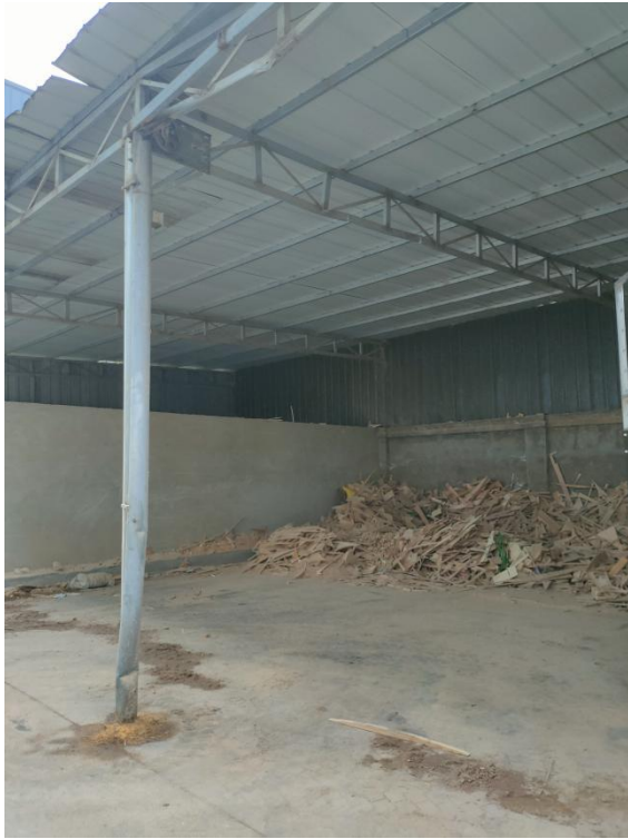
一般固废暂存间
