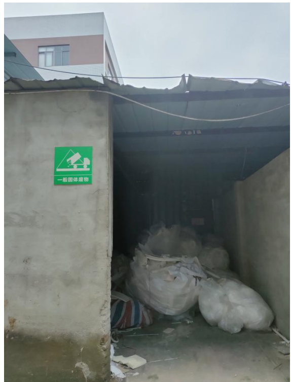
一般固废暂存间
