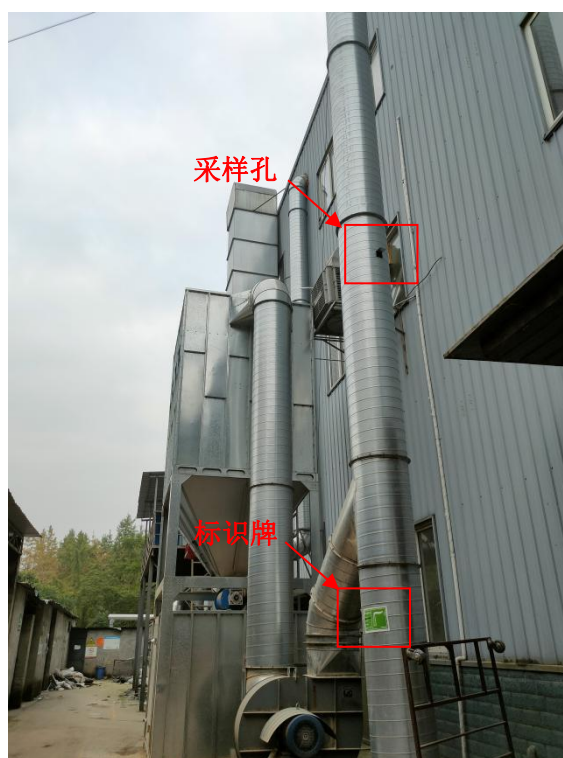
排放口标识标牌及采样孔
