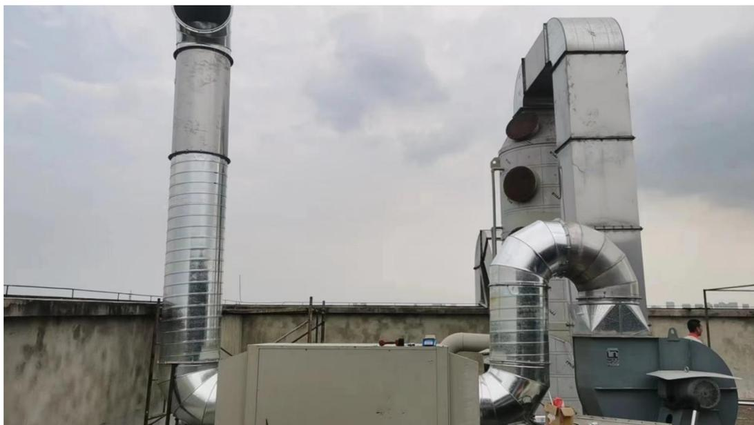
蒸煮废气与实验室无机废气共用1套“碱喷淋+UV光解”装置及排气筒
