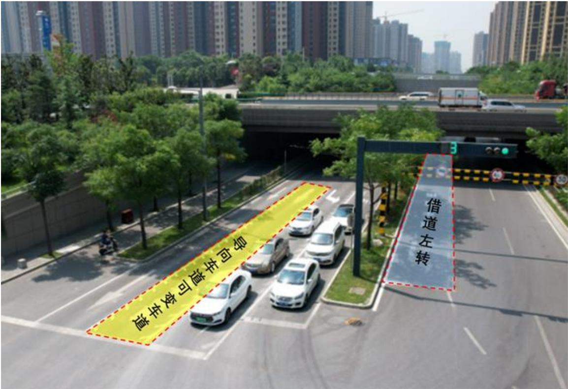
图9-1 借道左转+可变车道示意图
