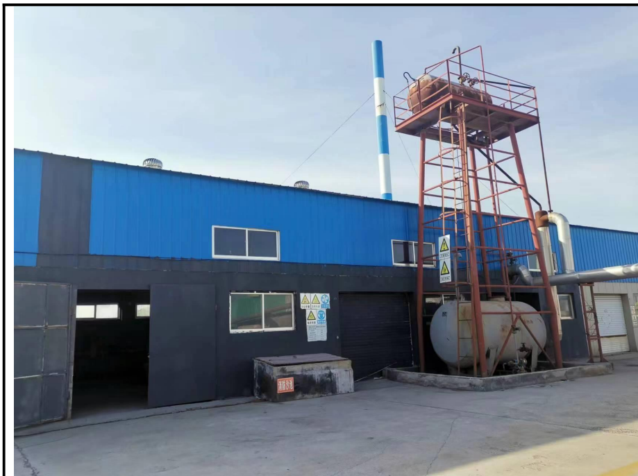
生产车间外部
