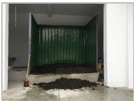
脱水污泥接收仓(半地下式)
