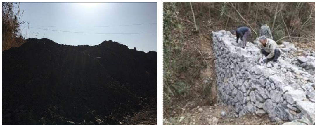
图 4-3 排土场和挡土墙
