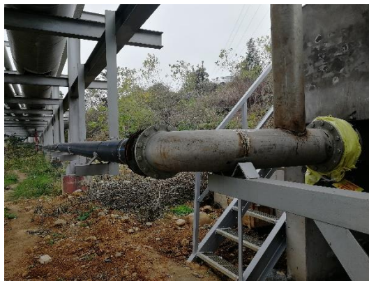
废水排放口（管道排放至金桥污水处理厂）
