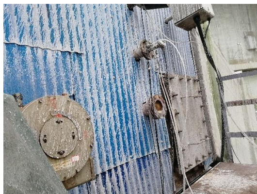
锅炉烟气在线监测装置
