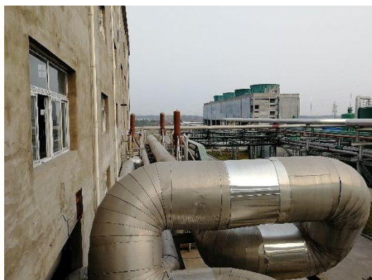
锅炉排气口消声器
