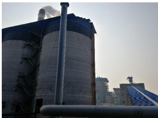
燃煤输送破碎废气排放口
