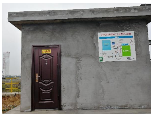
废水在线监测监控室
