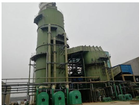
风机安装隔声罩
