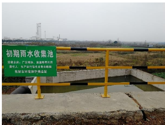
初期雨水收集池
