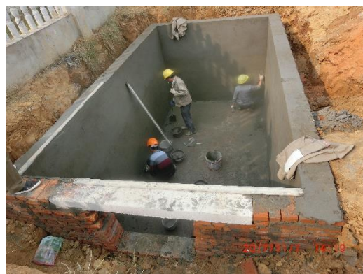
初期雨水收集池施工期
