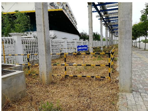
初期雨水收集池
