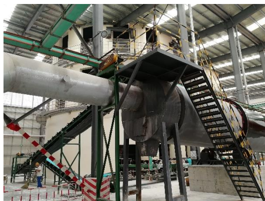
二期一冷进口废气测点
