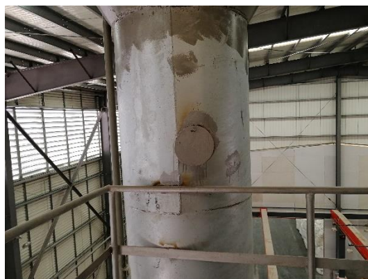
高塔复合肥投料粉尘废气出口测点
