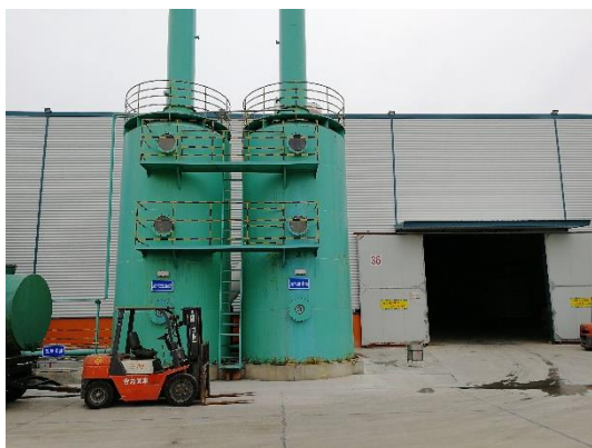
热风炉排气筒测点
