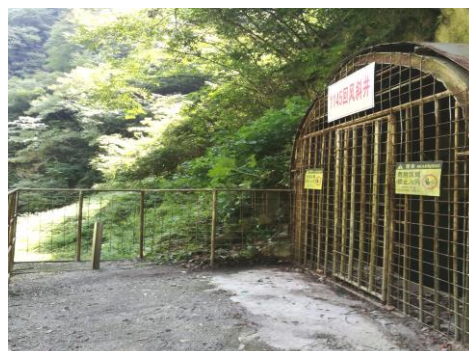
1145 回风斜井工业场地
