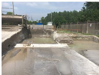
生产废水沉淀池
