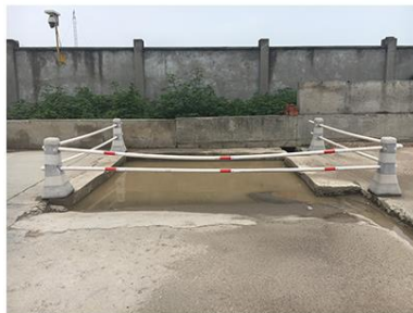
场地雨水沉砂池
