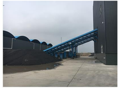
原料输送廊道
