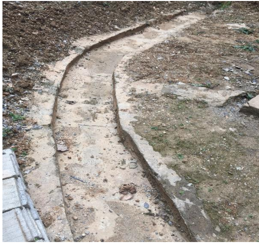
1 号风井截排水沟
