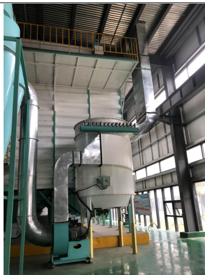
图 3-3 卸料粉尘排气筒 DA001
