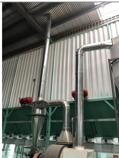
图 3-5 翻板冷却粉尘排气筒 DA002
