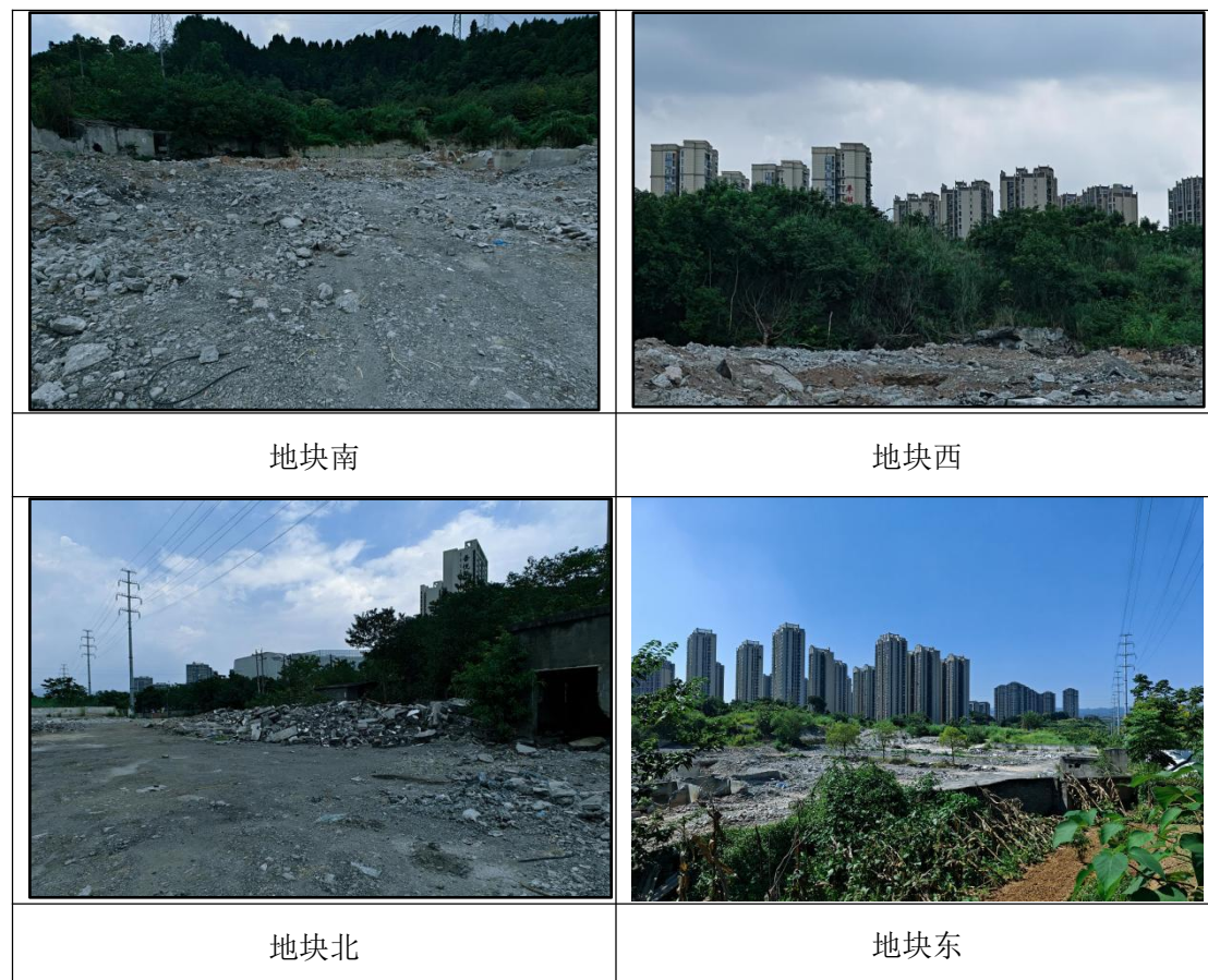
图 3.4-1 地块内部现状照片
