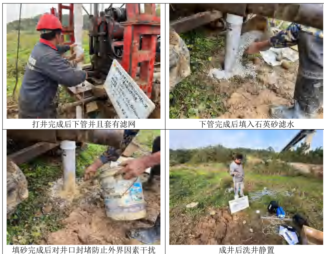
图 7.2-3 地下水建井质控现场
