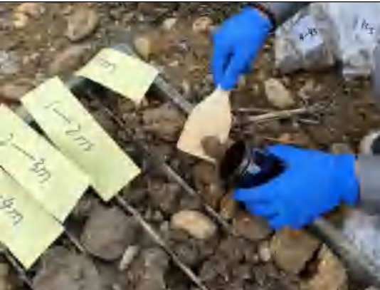
土壤样品 SVOCs 取样
