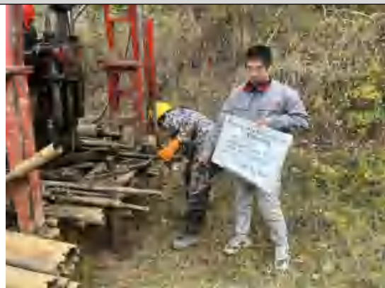
实际建井位置
