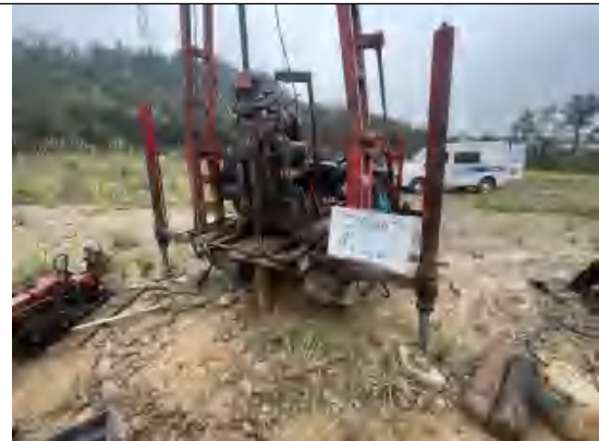
S4 土孔钻探场景
