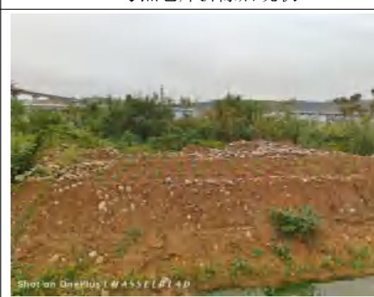
14号点仓库拆除后现状
