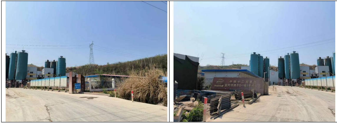
图3.4-1 西南侧地块现状照片
