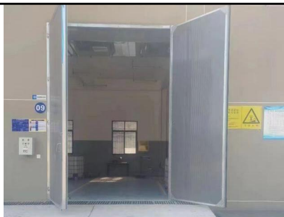
现有厂区危废暂存间（外）
