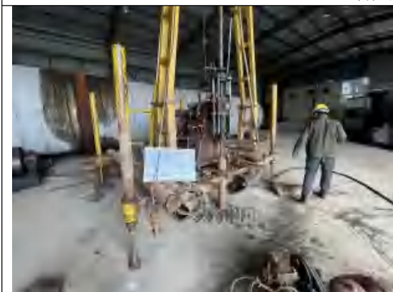
T03 土壤点钻探取芯过程
